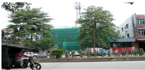
《 破壊され修理中の保安隊事務所 》
